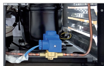
Valvola per sbrinamento a gas caldo Hot gas defrost valve
